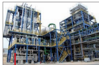
L'usine Kem One de Lavéra est à l'origine de 40% de la production française de chlorure de vinyle monomère.
